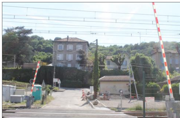
Le passage à niveau est de nouveau ouvert à la circulation.
